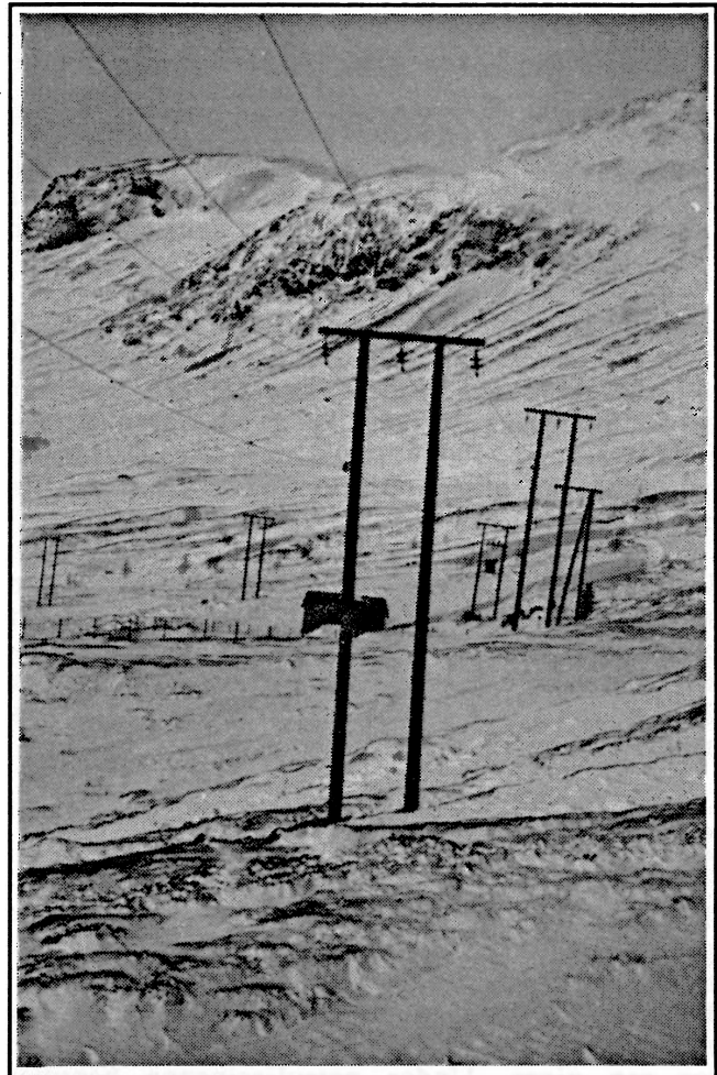
Figur 3 Parti fra 20 kV kraftledning på Hemsedalsfjellet som patruljeres for å finne eventuelle kollisjonsdrepte fugler. - A section of the 20 kV power line on Hemsedalsfjellet that is being patrolled to find birds killed through colliding with wires.
